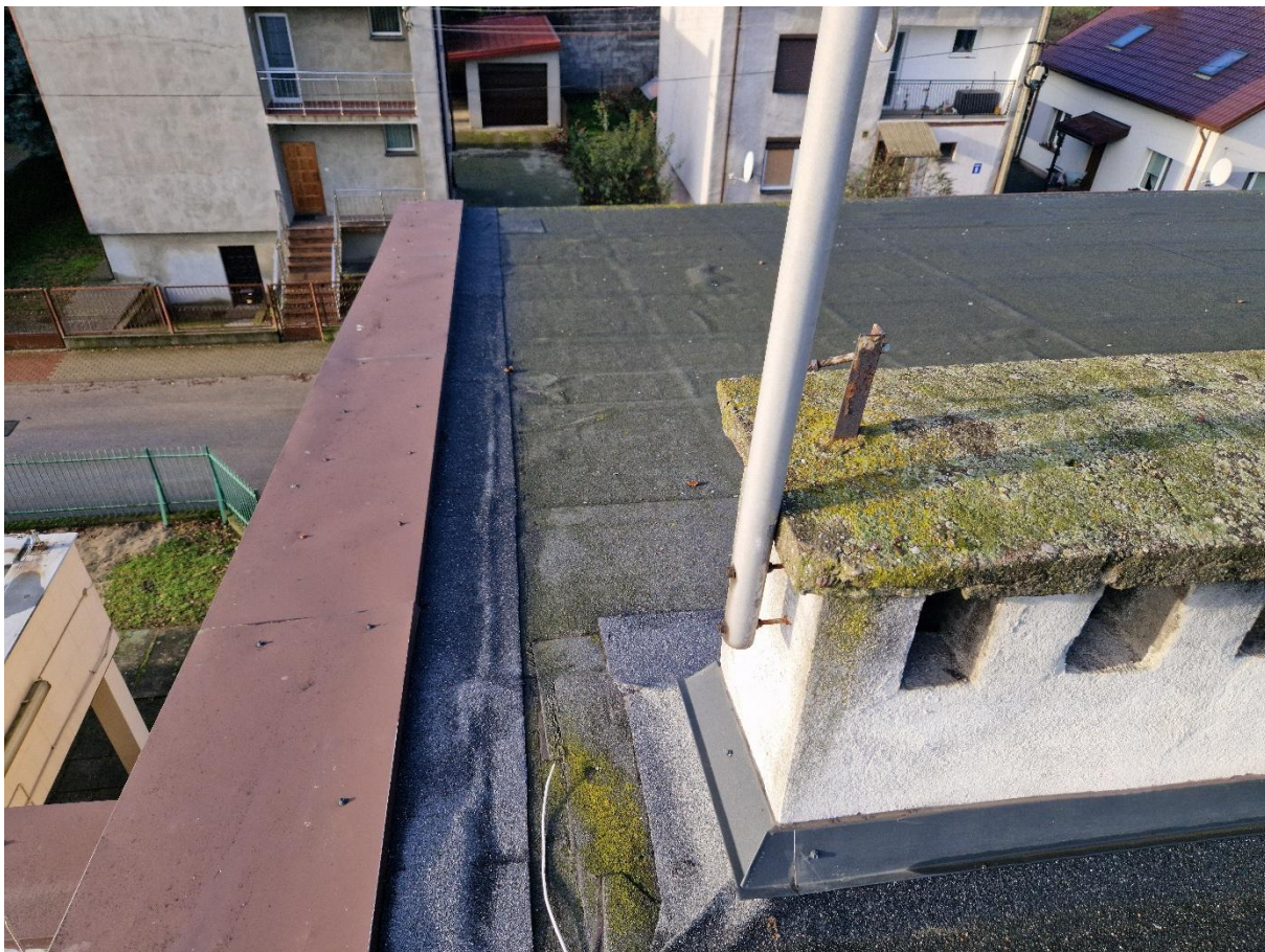
Zdjęcie 16 Prace naprawcze prowadzone w rejonie ogniomurów. Czapy kominowe z wykruszeniami i porośnięte mchem
