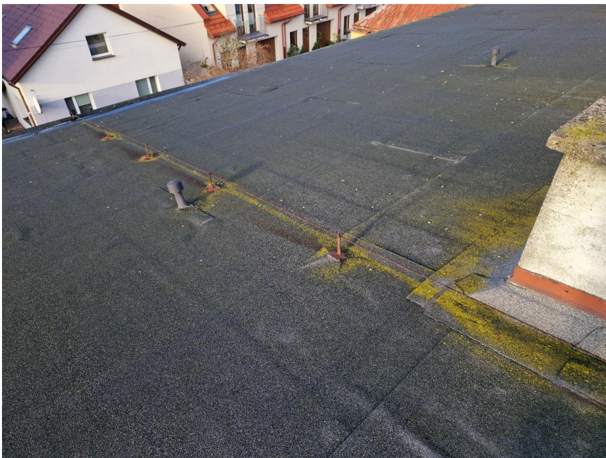
Zdjęcie 19 Instalacja odgromowa montowane bez uszczelnienia do połaci
