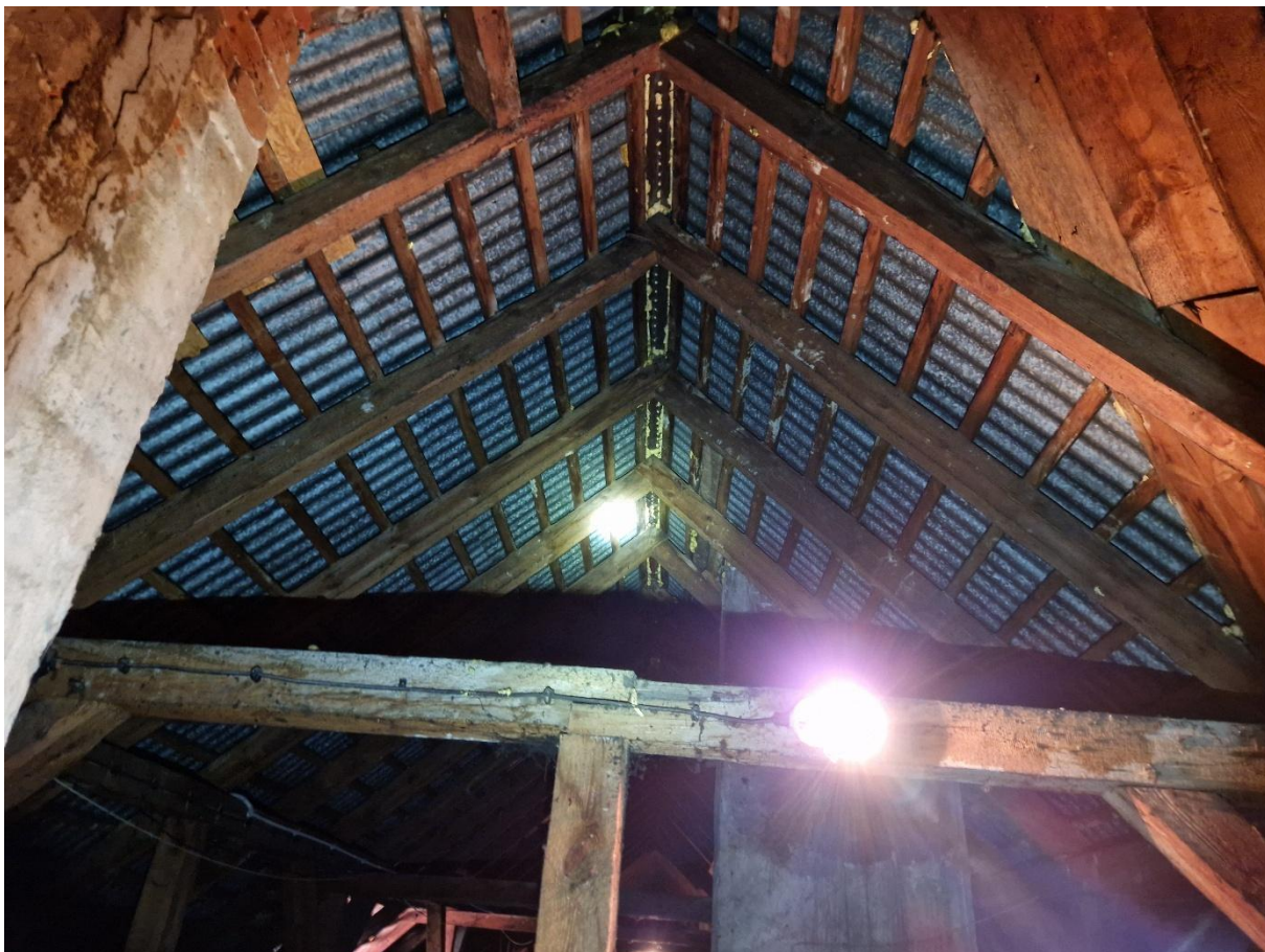
Zdjęcie 12 Próby uszczelniania w kalenicy
