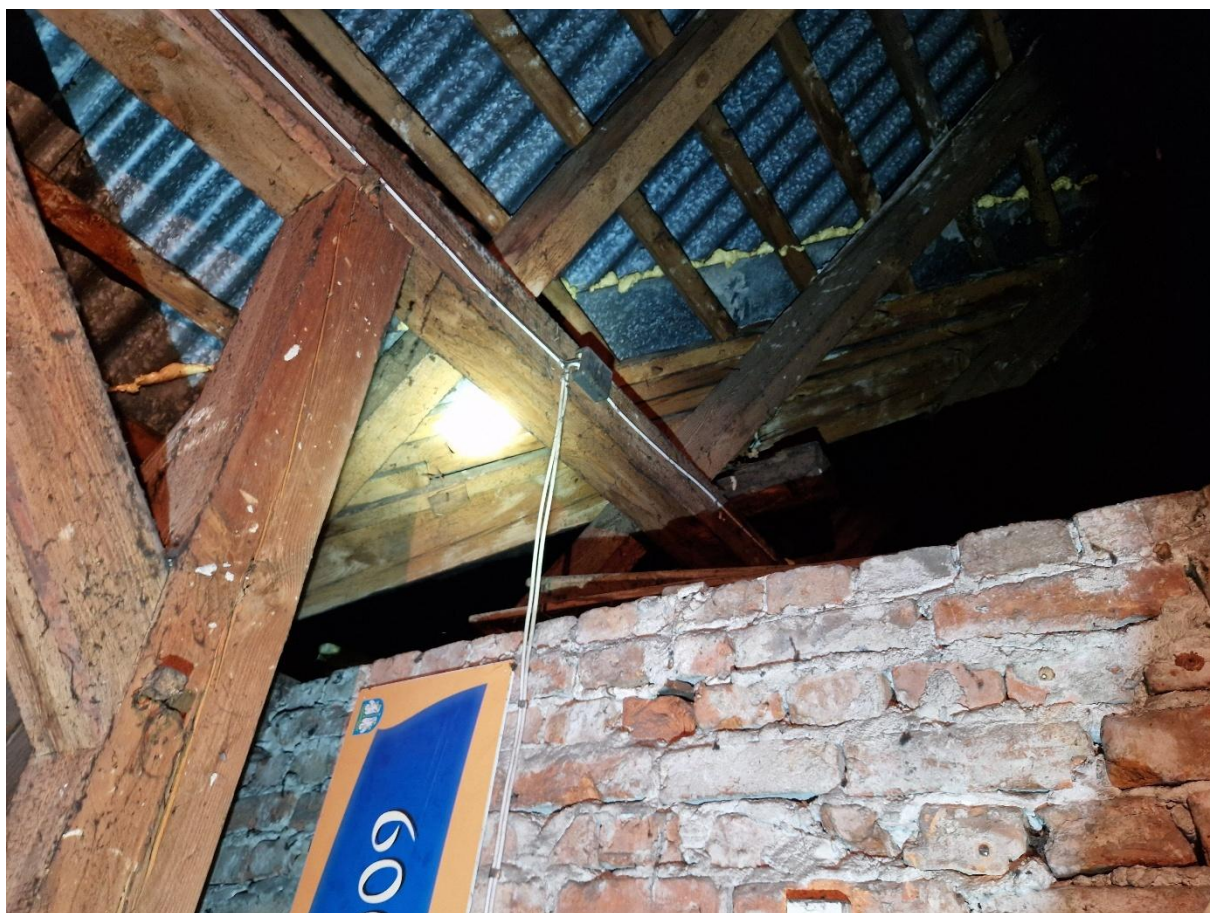
Zdjęcie 4 Uszczelnienie dachu pianą montażową w rejonie kosza
