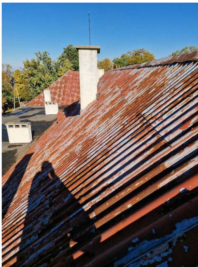
Zdjęcie 10 Łuszczenie powłoki malarskiej. Skorodowane obróbki kalenicowe
