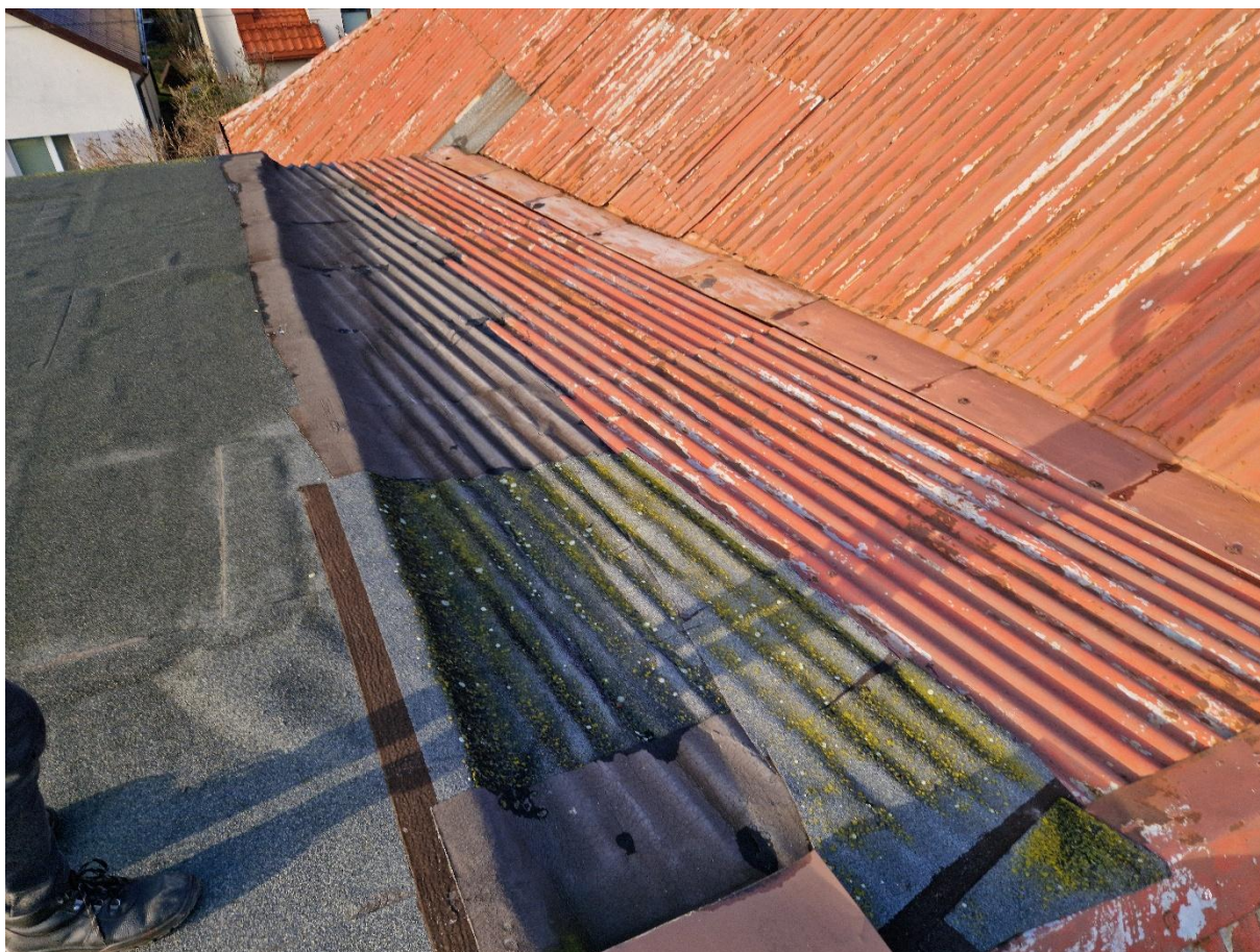
Zdjęcie 21 Styk obu części. Wykonać nowy ogniomur
