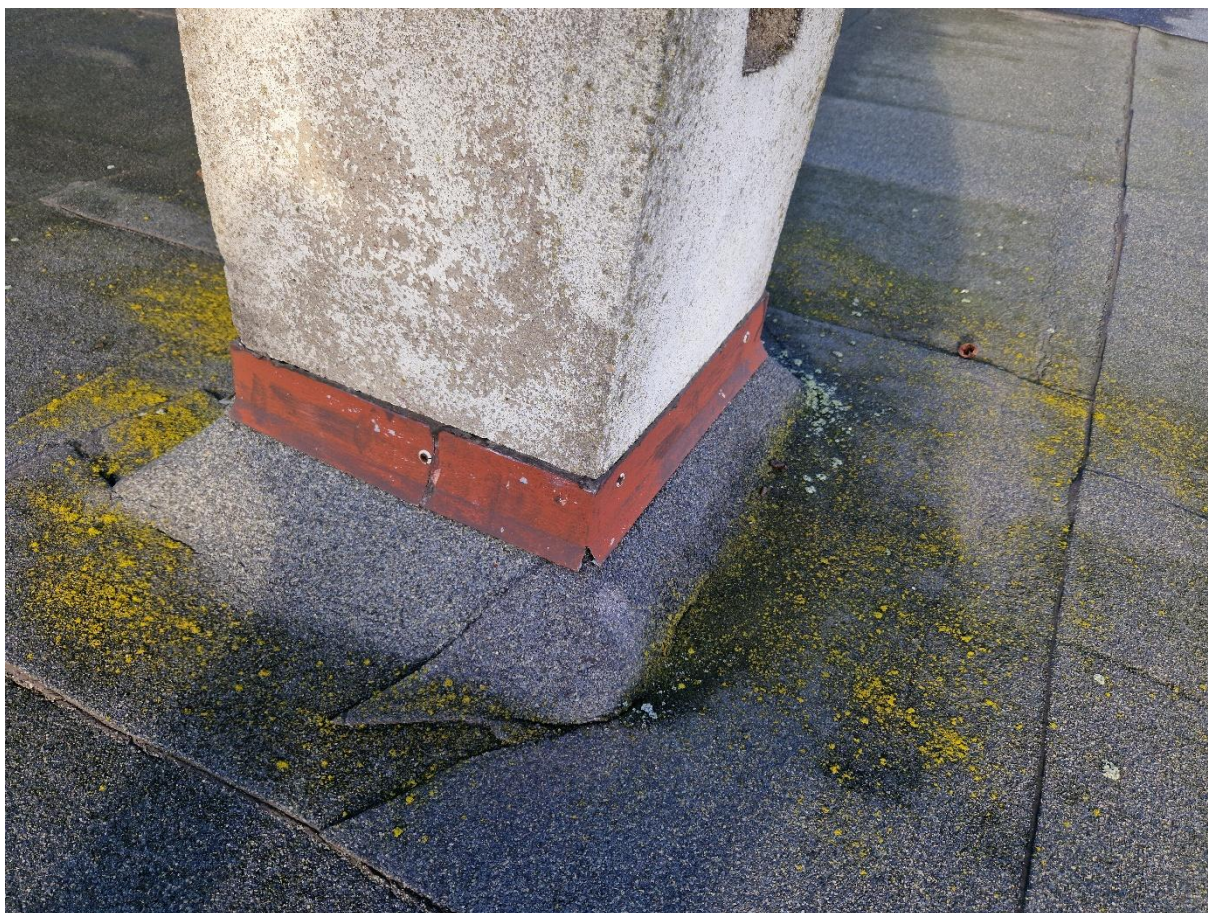
Zdjęcie 17 Niewymienione obróbki blacharskie kominów
