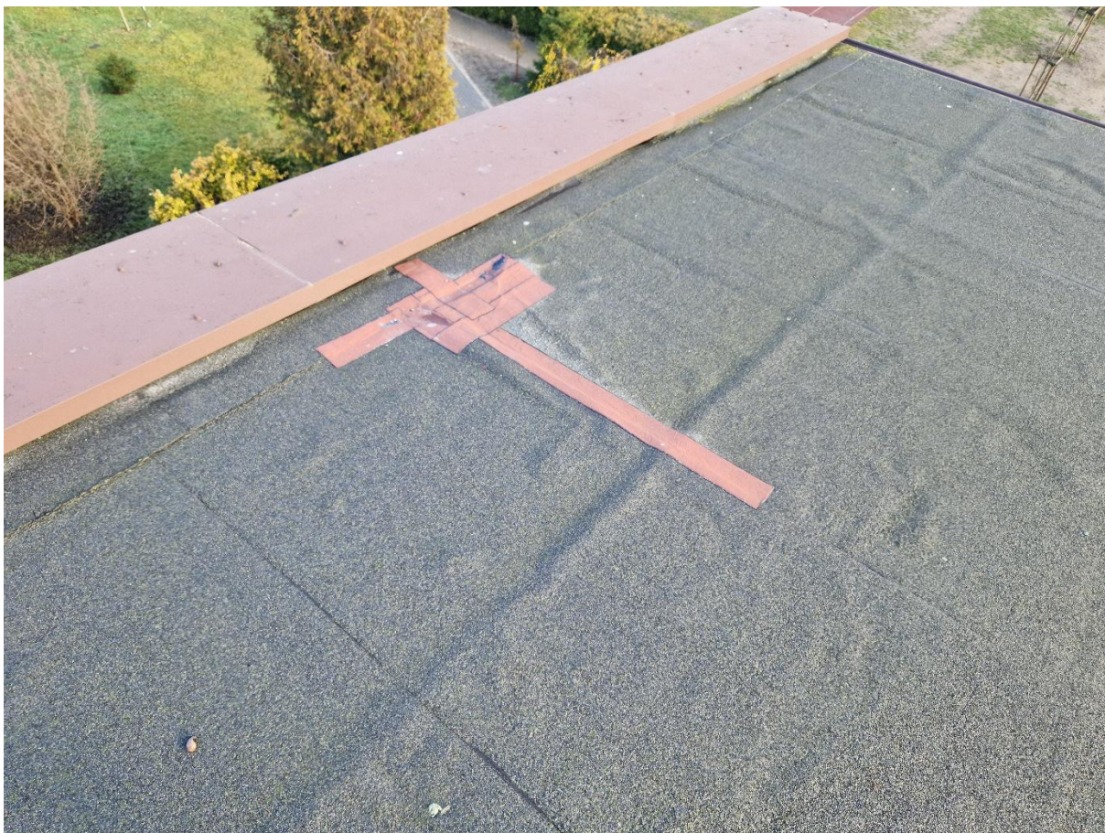
Zdjęcie 20 Bieżące naprawy dachu taśmami bitumicznymi
