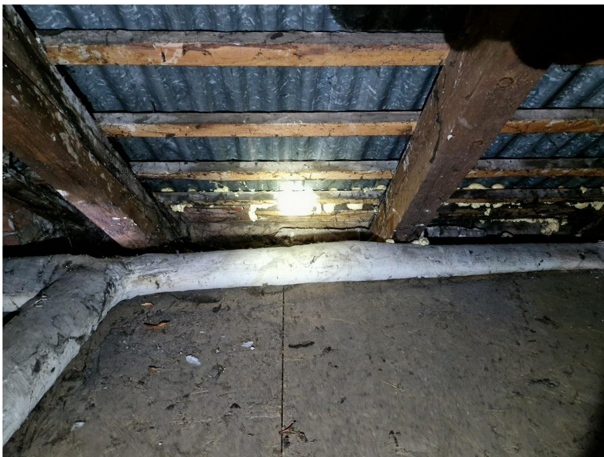
Zdjęcie 6 Zły stan deskowania w rejonie rynnowym - uszczelniany pianą montażową
