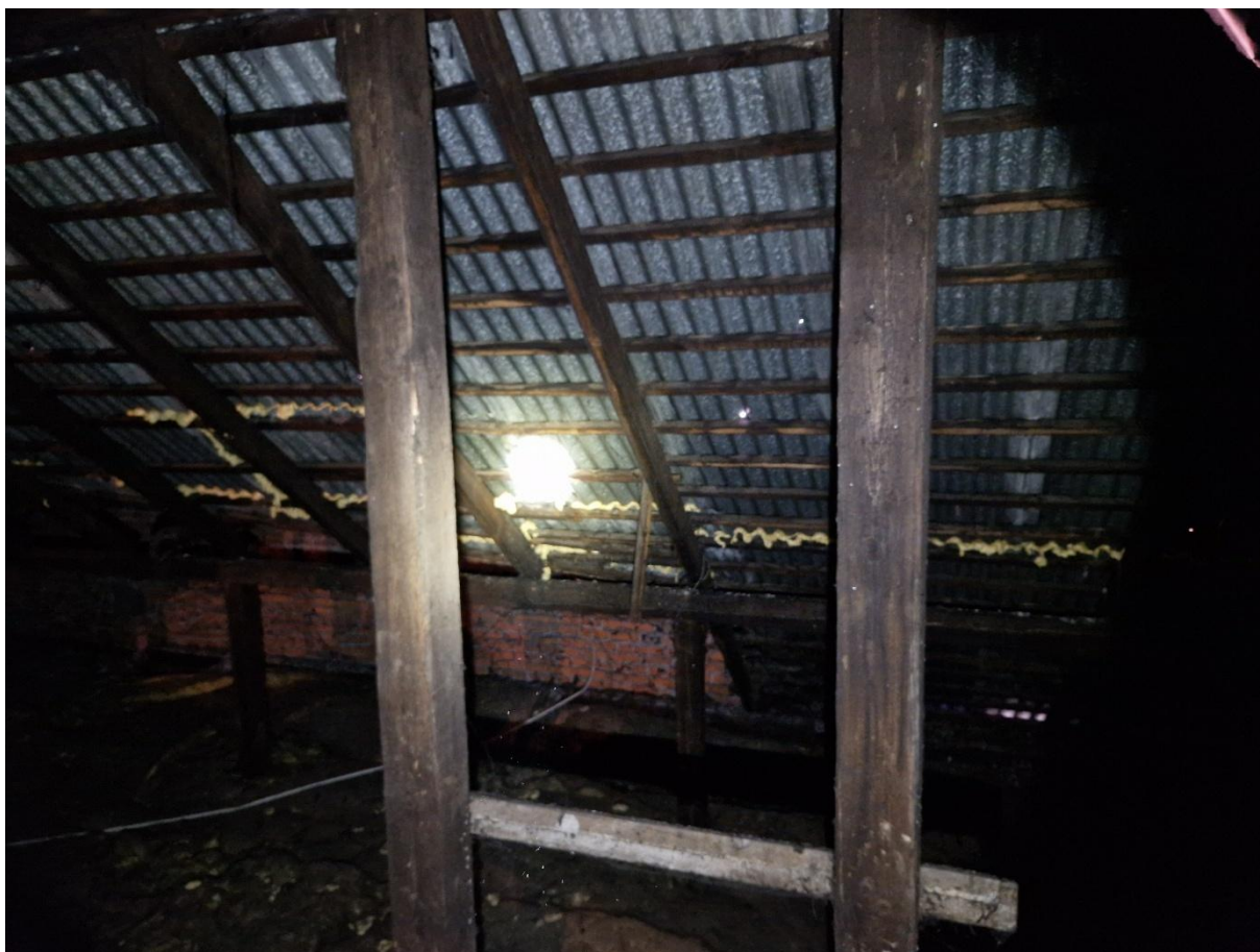
Zdjęcie 5 Uszczelnienie połączeń pomiędzy arkuszami - część południowa dachu
