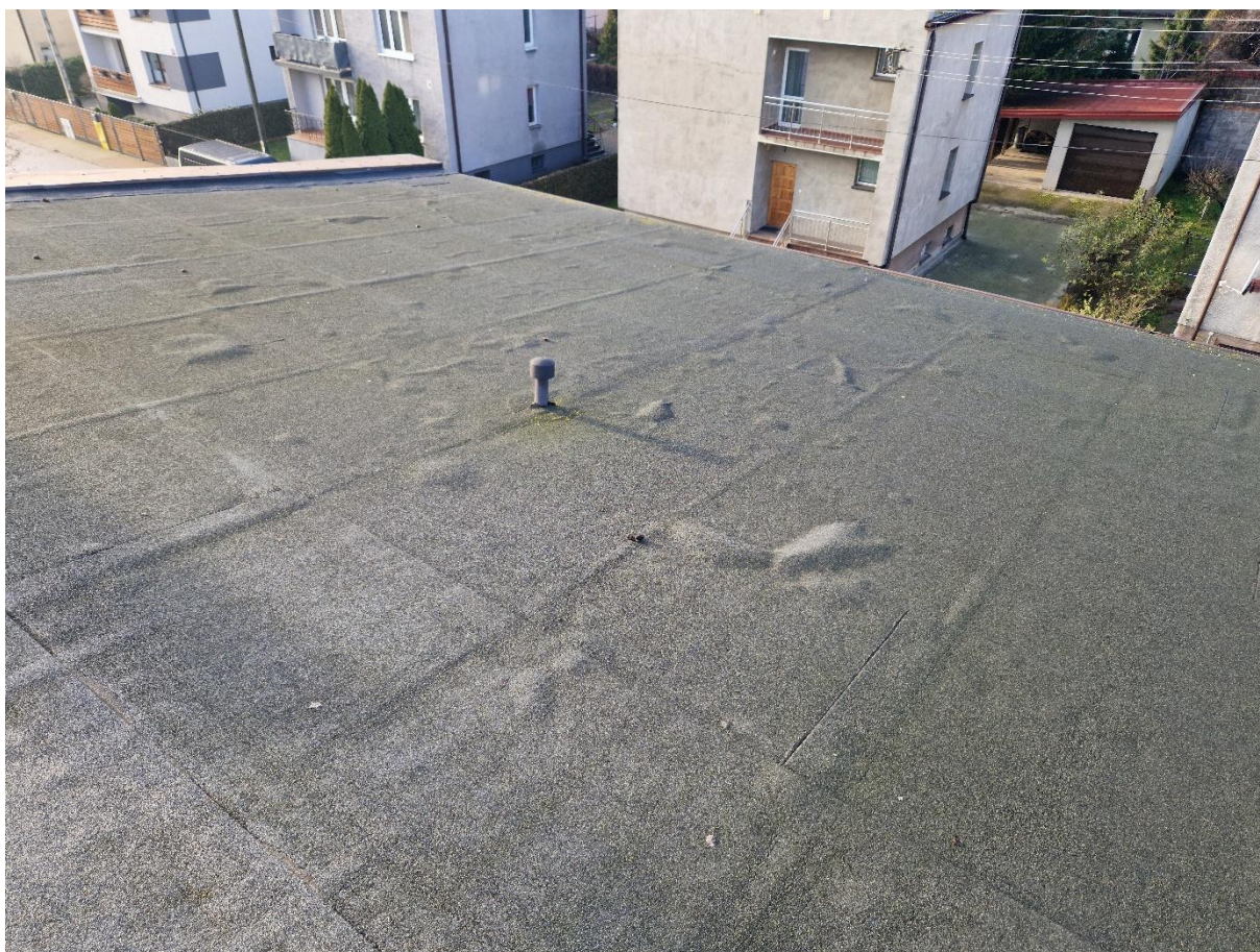
Zdjęcie 18 Pokrycie z licznymi pęcherzami powietrza
