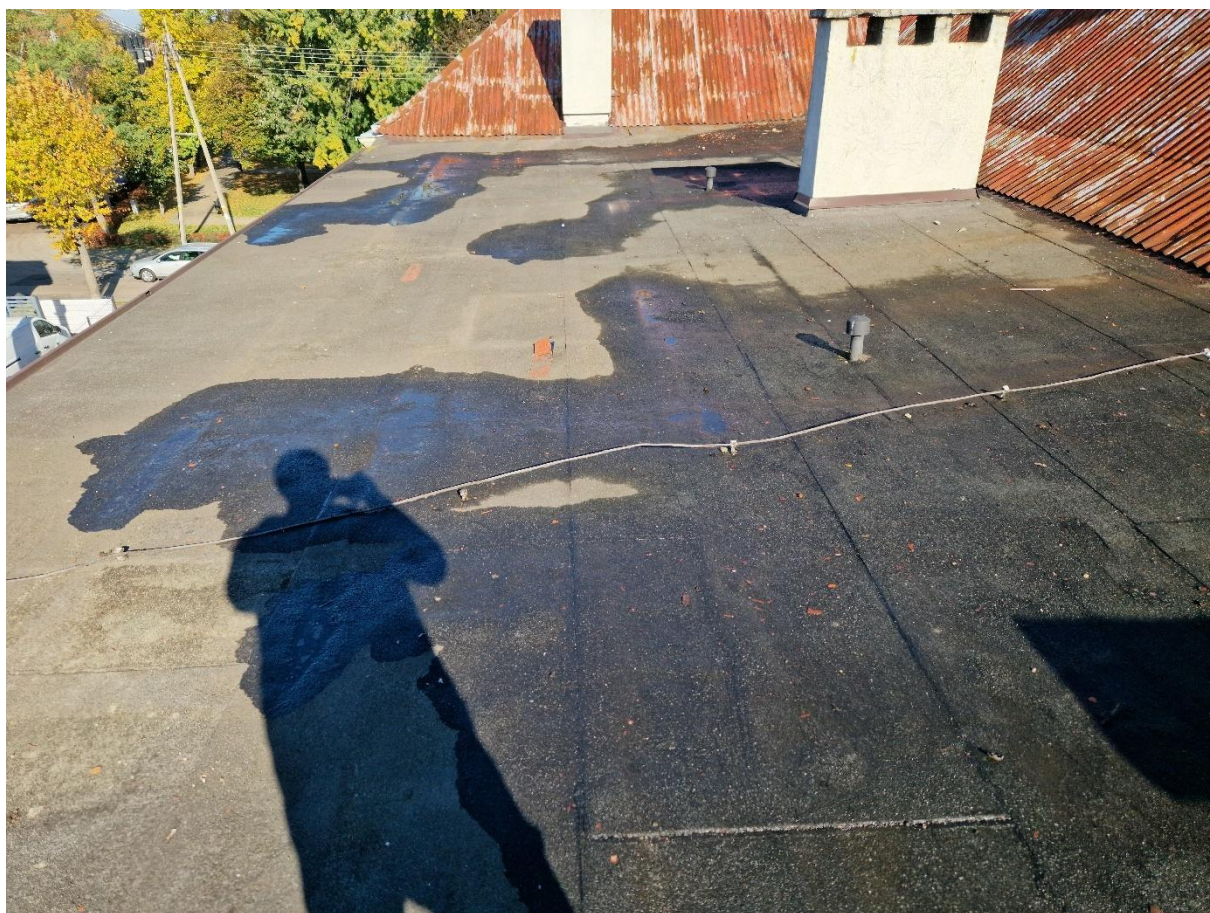
Zdjęcie 8 Zastoje wody na stropodachu części starej
